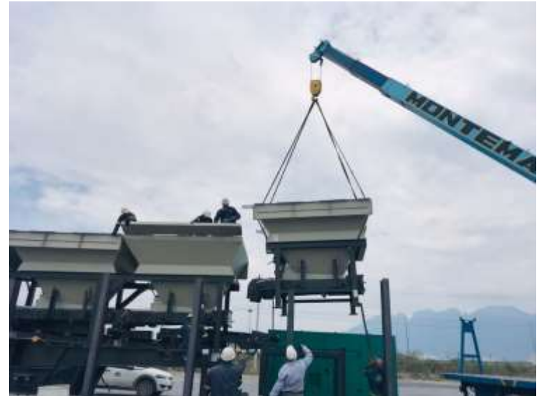
Montagem do quarto silo de agregados
