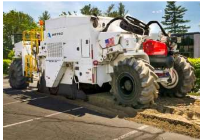
Reciclagem in-situ de pavimentos asfálticos
