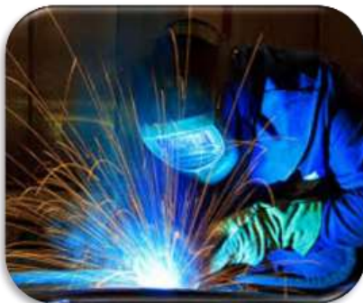
ESTRUTURA DE CALDEIRARIA
