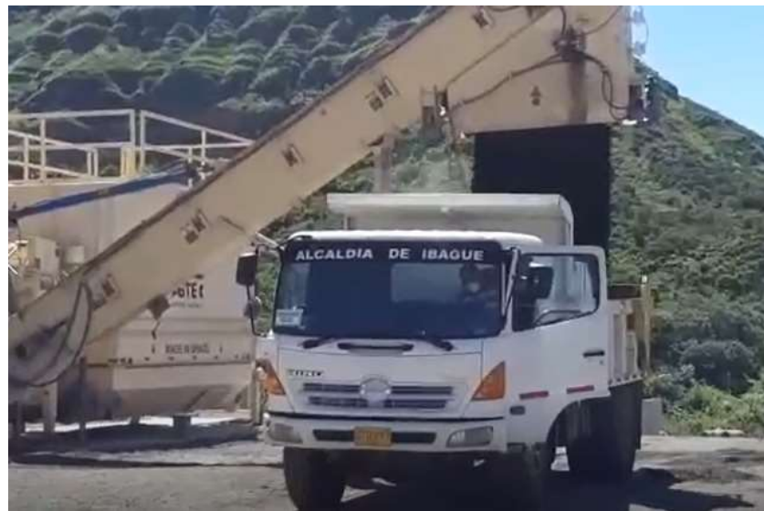
Usina Voyager em operação na Colômbia
